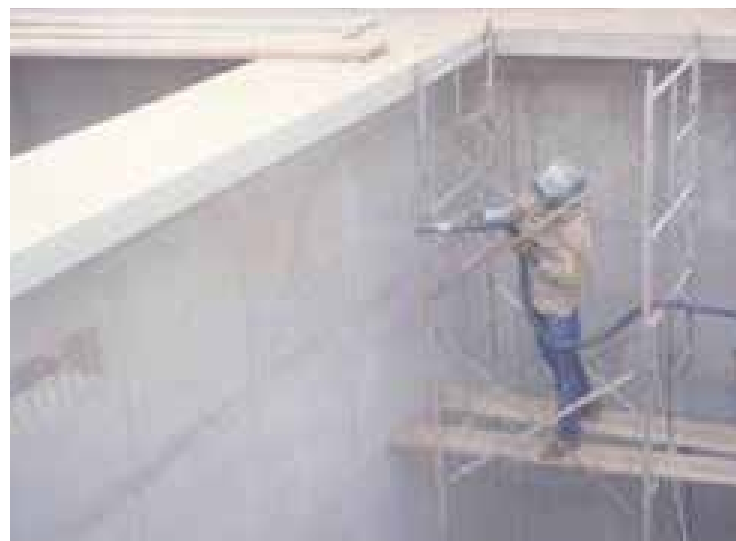
Jateamento e Revestimento em Tanques de Concreto
