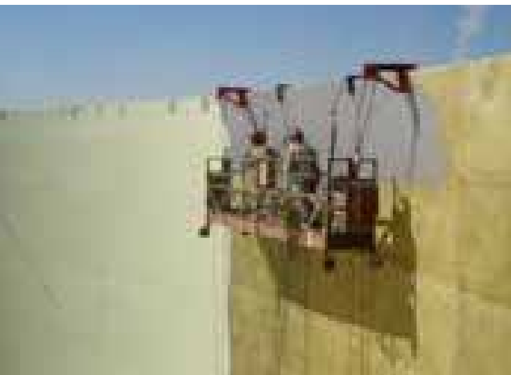
Revestimento Interno de Tanques Petróleo e Derivados
