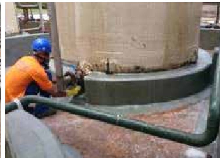
Revestimento de Diques e Bases de Tanques
