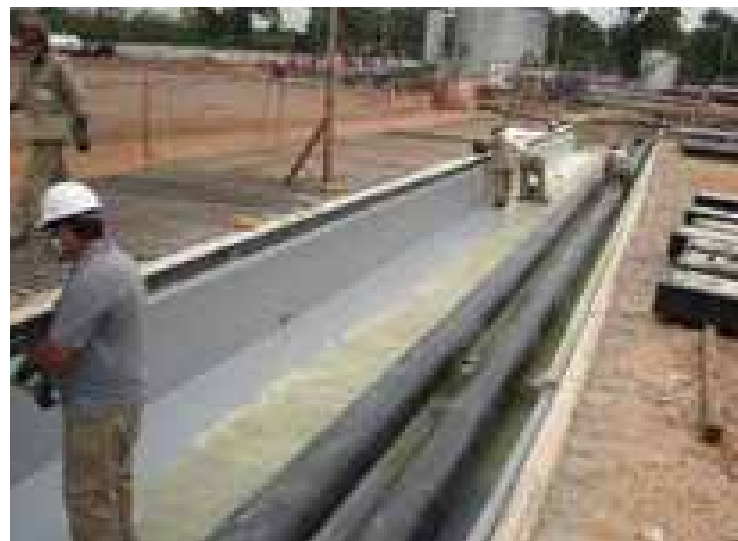
Revestimento de Canaletas E.T.E.
