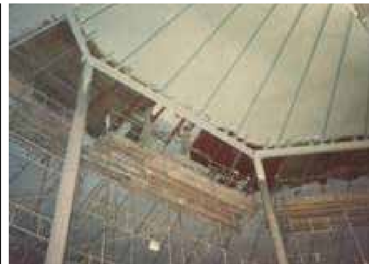
Revestimento Teto de Tanques
