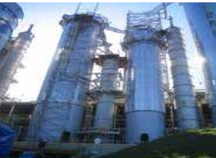
Torres de Branqueamento de Celulose
