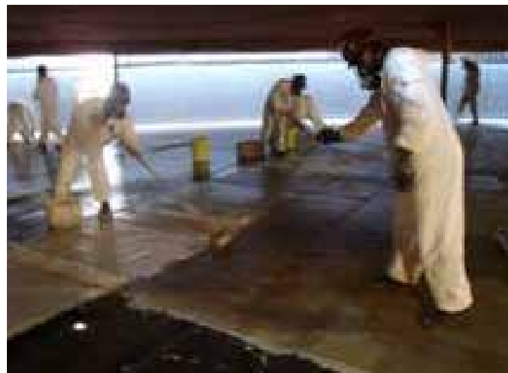
Reforço Anticorrosivo Fundo de Tanques
