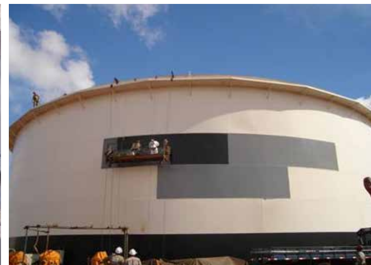
Recuperação e Reforço Estrutural Externa de Tanques - Fibra de Carbono
